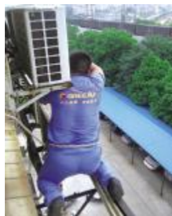
图为奋战在一线的湖南安装工
