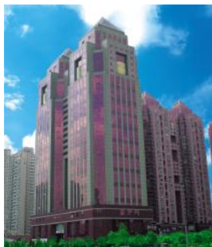
▲全部采用格力中央空调的深圳中银大厦
